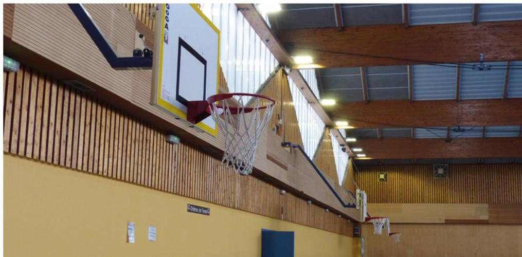
Des travaux d'éclairage ont été entrepris au complexe sportif évolutif couvert, une semaine avant Noël. L'équipement vieillissant et très énergivore datait de 1986. Les lumières intérieures ont été remplacées par des LED comportant un système de détection et de gradation en fonction de la lumière naturelle et extérieure.
